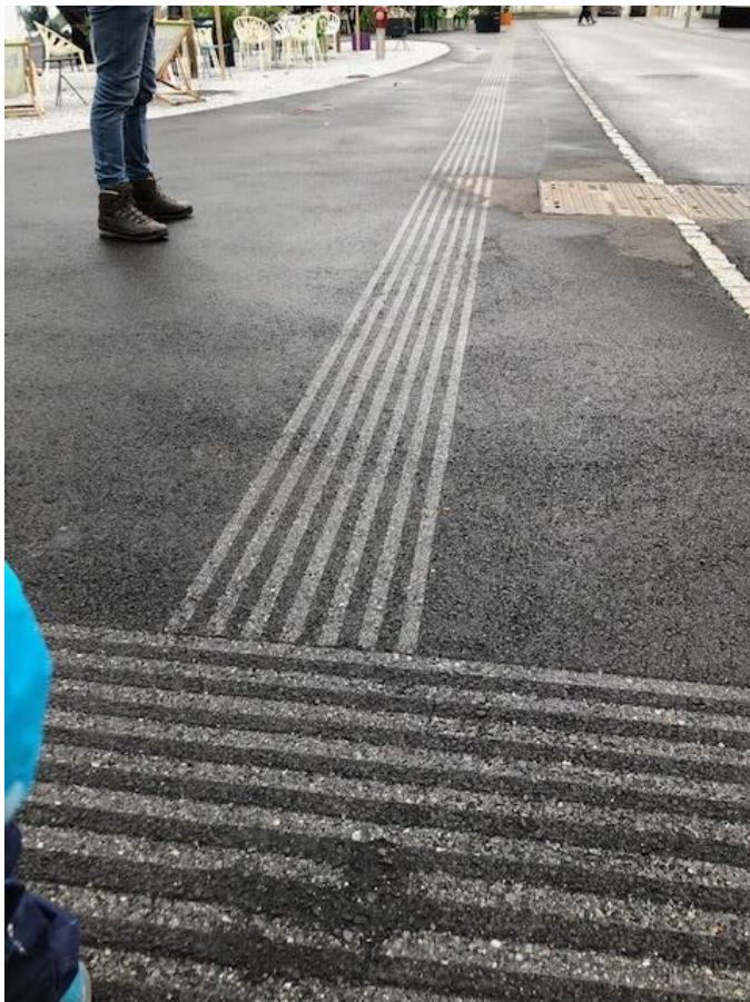
Übersichtsbild Abgrenzung zwischen Fußgängerbereich links und Fahrbahn rechts
