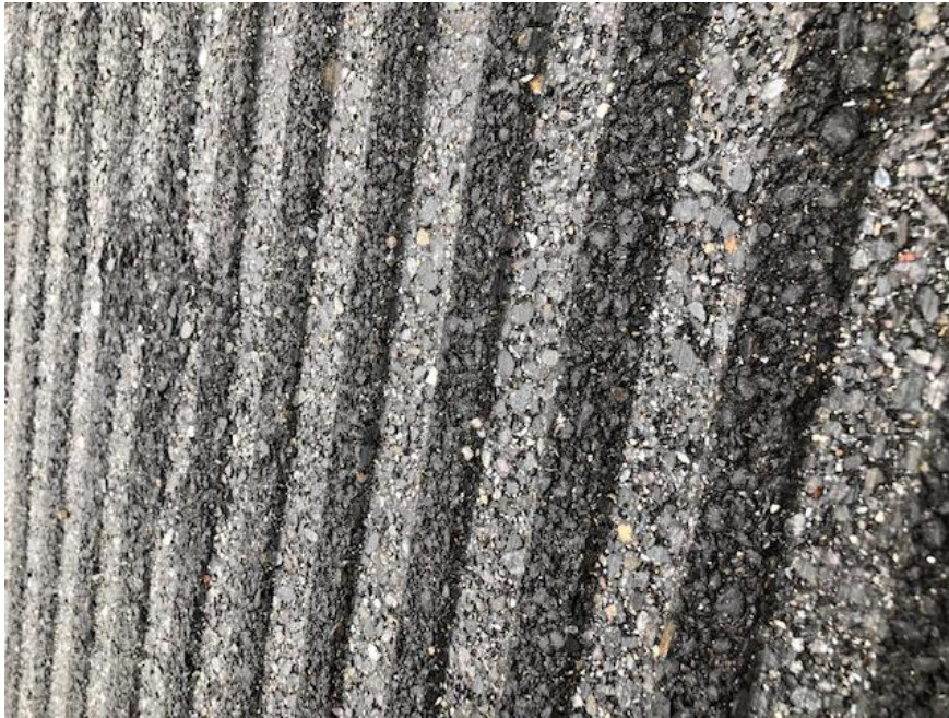
Nahaufnahme gefräste Rillen in Asphalt
